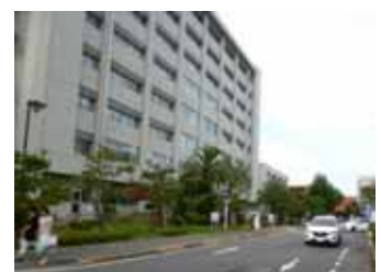
基礎・社会医学棟南面
