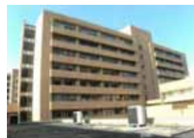
改修前建物（工学部）
