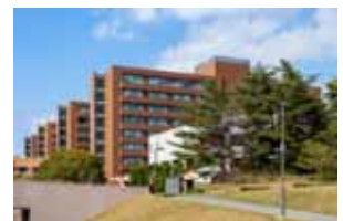
改修後建物（工学部）
