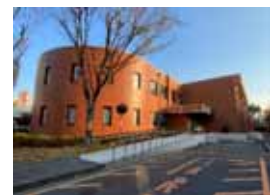
図書館改修完了
