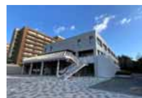
改修後建物（東図書館）
