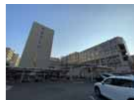
学部研究棟改修完了
